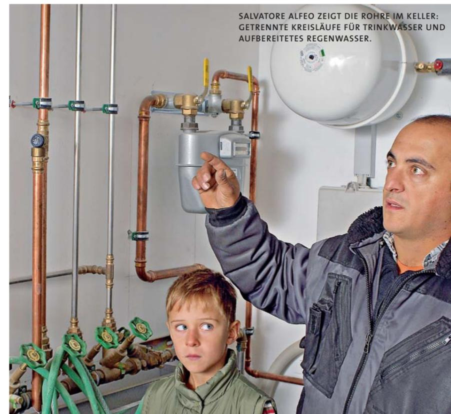
SALVATORE ALFEO ZEIGT DIE ROHRE IM KELLER: GETRENNTE KREISLÄUFE FÜR TRINKWASSER UND AUFBEREITETES REGENWASSER.
